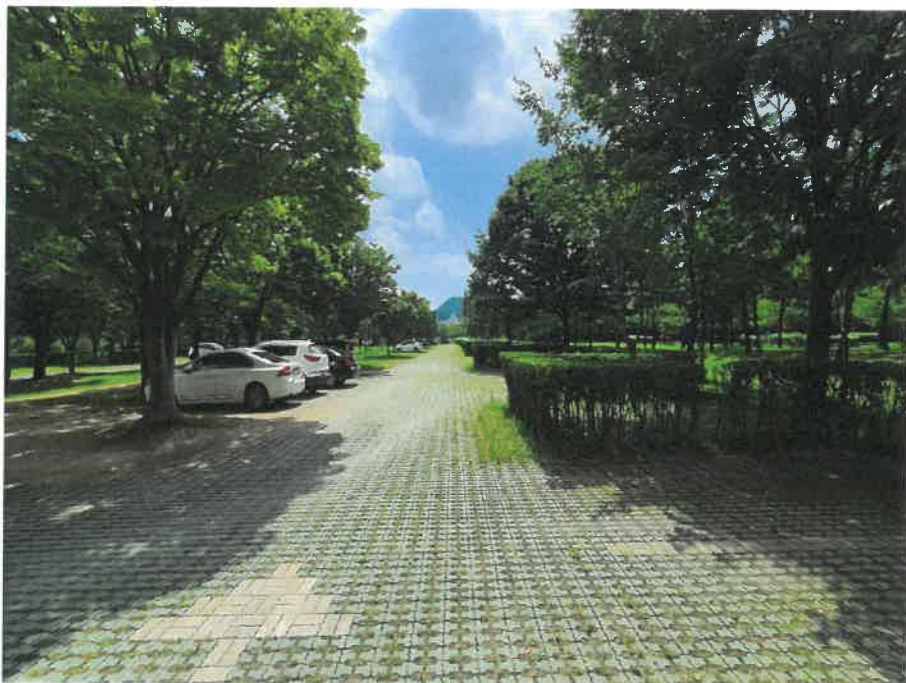
본건 일련번호(1) 전경
