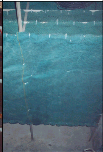
사진-6 시드니 모텔 신축공사 현장 중 오수처리시설현장, 사각 파이프에 고정시킨 Media
